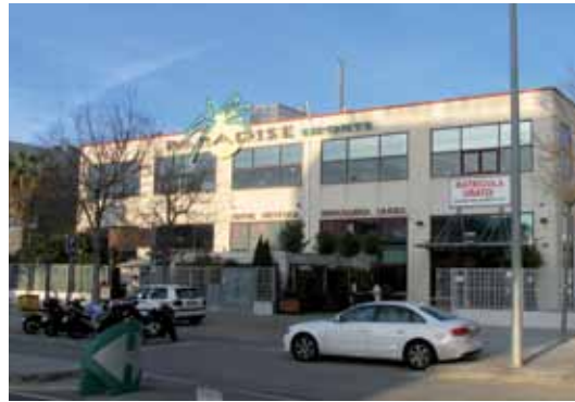
► El centre Paradise Esports disposa des de 2010 d'una instal·lació de trigeneració que cobreix el 90% de la seva demanda de climatització i ACS.
